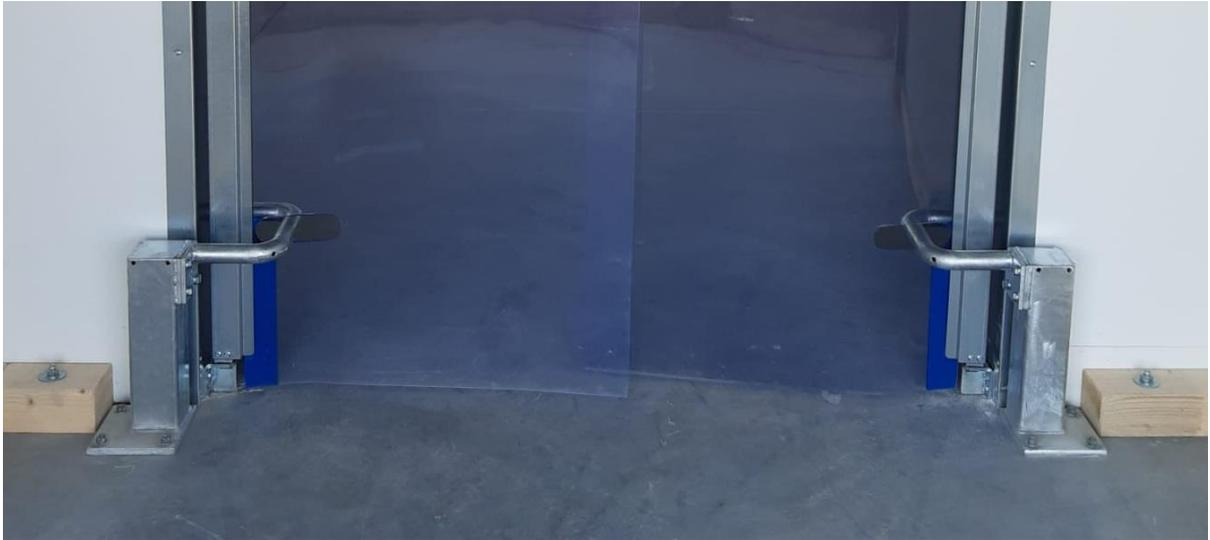
1. Montage der Umfassungszarge und Verschraubung der Torflügel an der Zarge. (siehe Montageanleitung „Pendeltür FK-M250 mit Umfassungszarge“)
